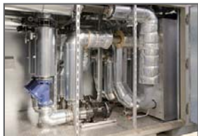
Mobile Technikcontainer und Übergabestationen
