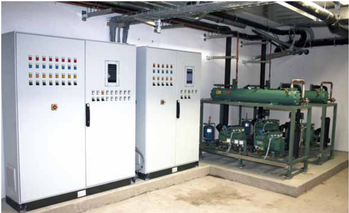
Die von UNGERMANN eingesetzten halbhermetischen Kompressoren sind ebenso wartungsfreundlich wie leistungsstark und werden in einem speziellen Maschinengestell im Maschinenraum nach Wahl an bestmöglicher Stelle innen oder außen aufgestellt. Die großflächigen Kondensatoren zur Außenaufstellung gibt es auch als spezielle „Leiseläufer“ mit nur 35-40 dB/A in 5 m Entfernung.
